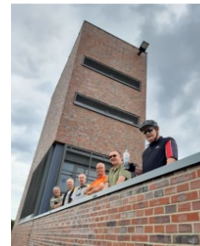
Am Emscher Sperrwerk in Ikern
